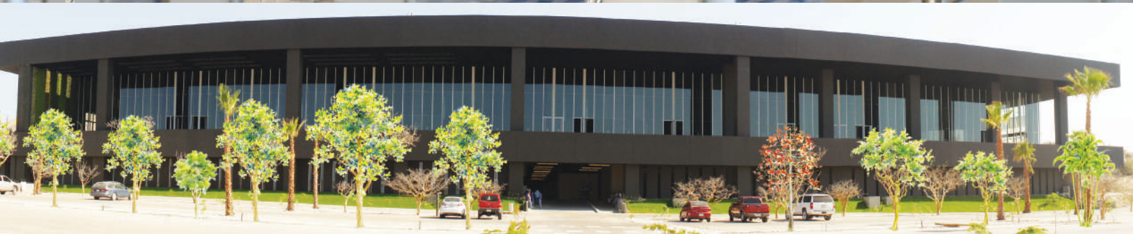
SISTEMA DE CABLES CENTRO DE CONVENCIONES LOS CABOS (G-20) Instalado por: TECNOVIDRIO
